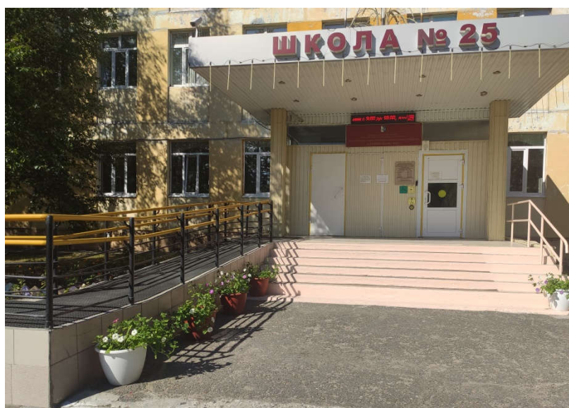
Вход в школу
